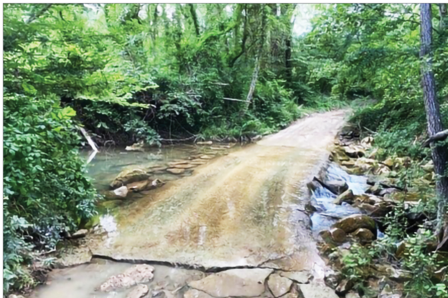
Slika 4: Utrditev dna in znižanje brežin zaradi prehoda čez strugo (fotografija: Lea Prodan, 16. 6. 2020)
