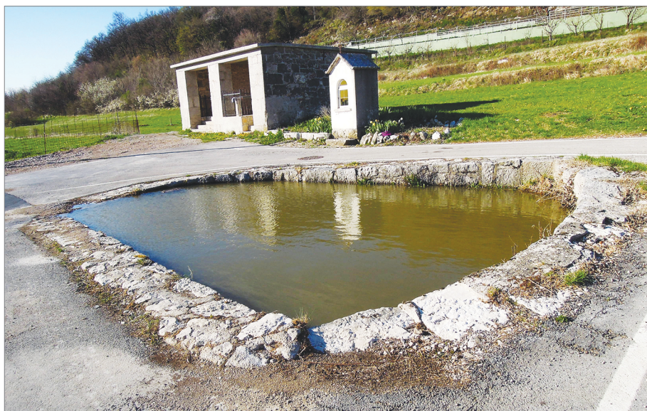
Slika 5. Nekdanji glavni vodni vir za oskrbo s pitno vodo v Rakitovcu, imenovan Skedenc (fotografija: Valentina Brečko Grubar, 3. 4. 2021)
